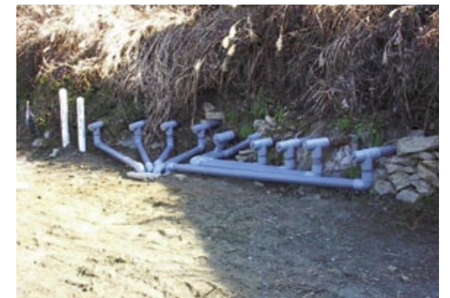
<排水ボーリング工の事業例> 大豊町東庵谷下地区
